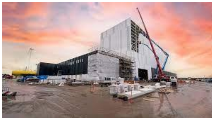
In Eemshaven bouwt TKH een ruim € 100 miljoen kostende fabriek voor offshore windkabels
