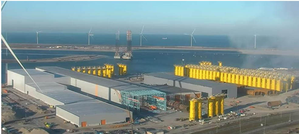
Nieuwe fabriek van SIF in aanbouw op de Rotterdamse Maasvlakte 2
